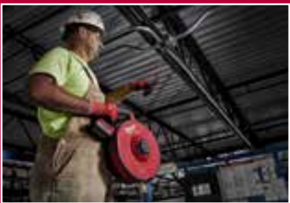
Alimentazione e ritrazione automatica della sonda
